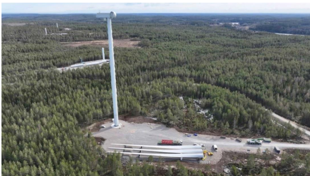
Figur 8. Eurowind monterar vindkraftverk av typen Siemens Gamesa SG170 med 200 m totalhöjd.
