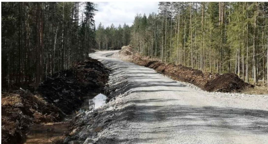
Figur 9. Exempel på breddning av befintlig väg.
