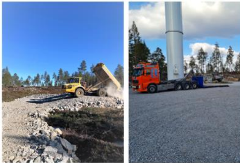
Figur 30. Anläggningsarbete som utförs av lokala underentreprenörer i vindpark Knöstad, Säffle kommun.
